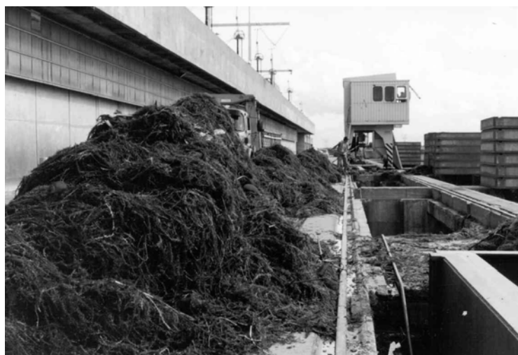
Figura 3. Material colhido, composto principalmente por plantas submersas, pelo pórtico limpa-grades da Usina Hidrelétrica Eng. Souza Dias
